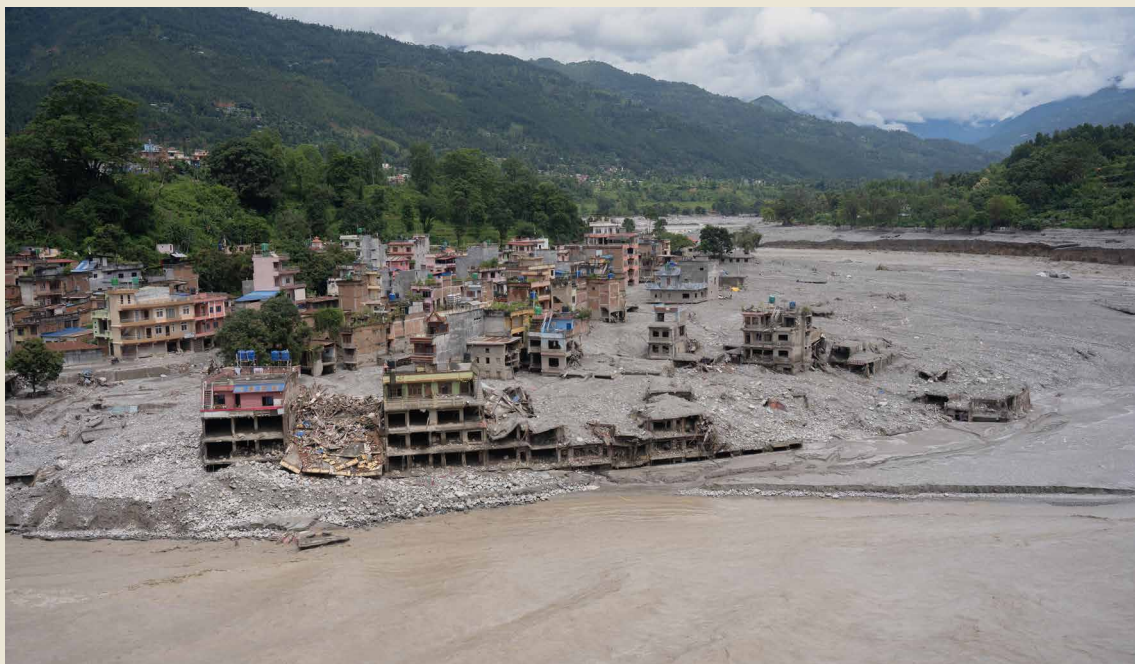
Casas danificadas pelas inundações em Trishuli Bazaar, Nuwakot. Foto: Sharada Bashyal/Oxfam
