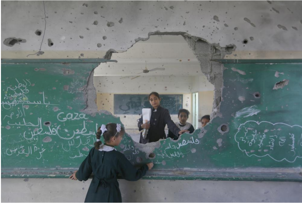
Manar, de 11 años, y sus amigas, en su colegio en Gaza, que sufrió graves daños durante el conflicto de 2014: "Esta destrucción me da miedo. Las clases están demasiado llenas y el agua se filtra cuando llueve. Pero me encanta mi colegio." (2015) Foto: Iyad al Baba/Oxfam
