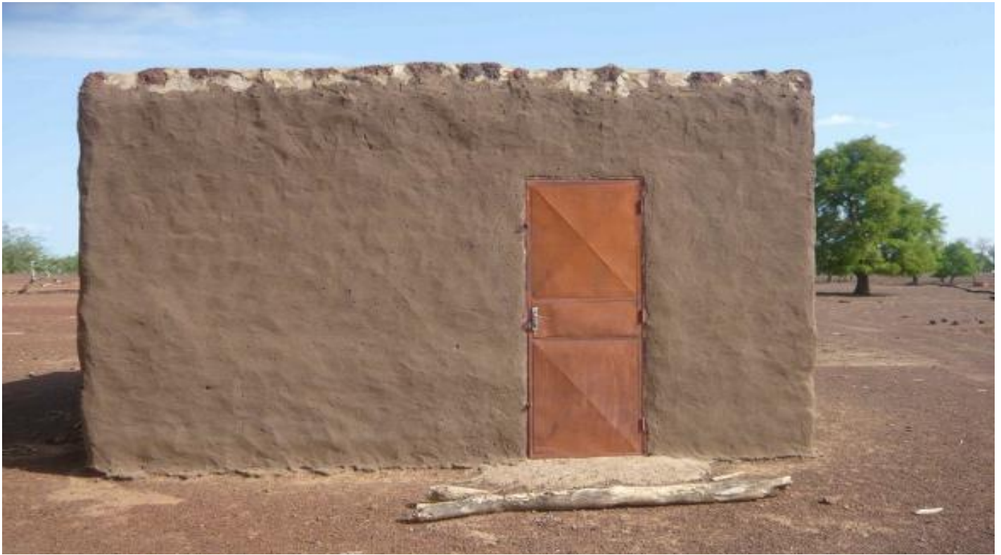
Grenier de sécurité alimentaire de Songa, département de Rambo, Burkina Faso.
